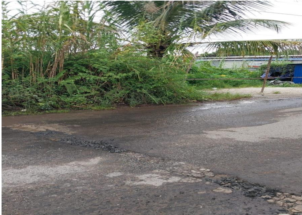
Gambar 0.4 Jalan yang sudah diperbaiki
