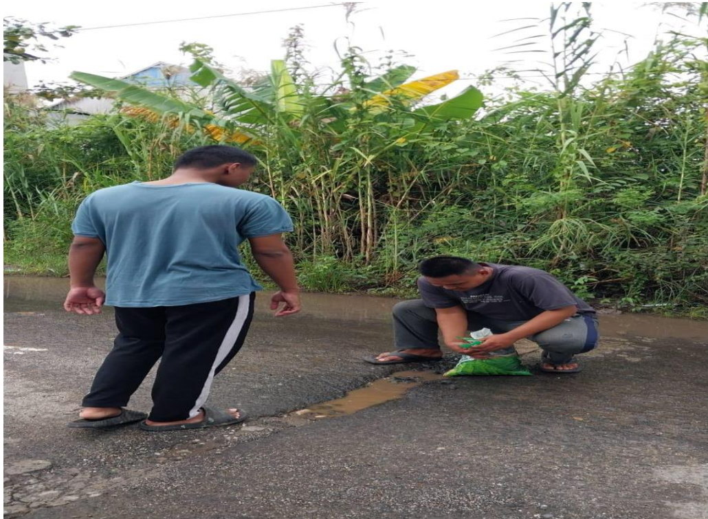
Gambar 0.3 Pengamplikasian bebatuan yang telah dikumpulkan untuk menutup lubang jalan.
