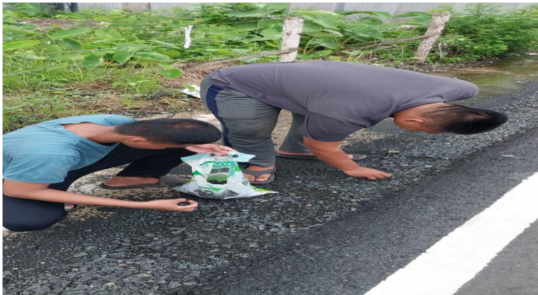
Gambar 0.2 Pemungutan bebatuan di sisi jalan untuk penutupan lubang jalan.
