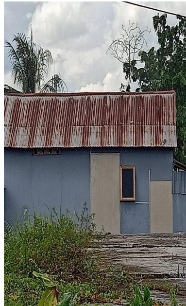
Gambar 4. Rumah telah di renovasi
